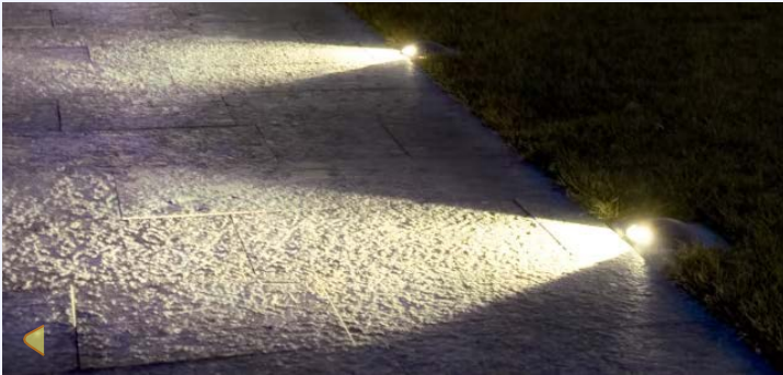
Bodeneinbauleuchte Bega entlang Hauptwege
