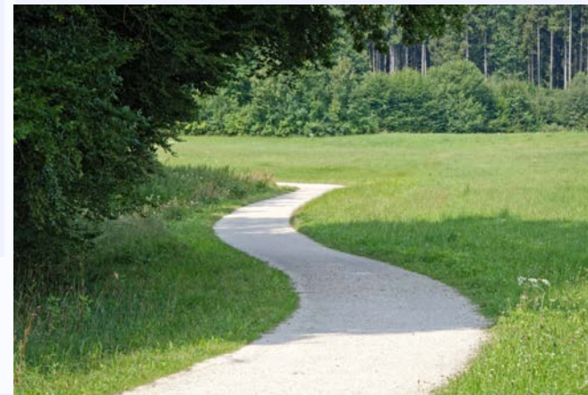
Schmaler Asphaltweg 2.50 breit, 60% Recyclingasphalt
