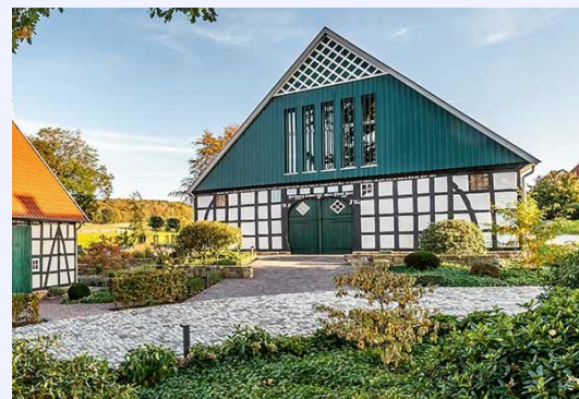
Pflaster Kombination Klinker hochkant und Naturstein
