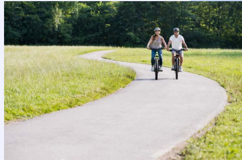
Schmaler Asphaltweg 2.50 breit, 60% Recyclingasphalt
